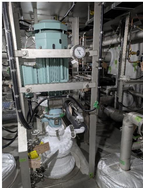
FGSS（ガス燃料をガス燃焼機器に送り出すユニット 右の写真下部の白い部分は極低温のため霜付）
